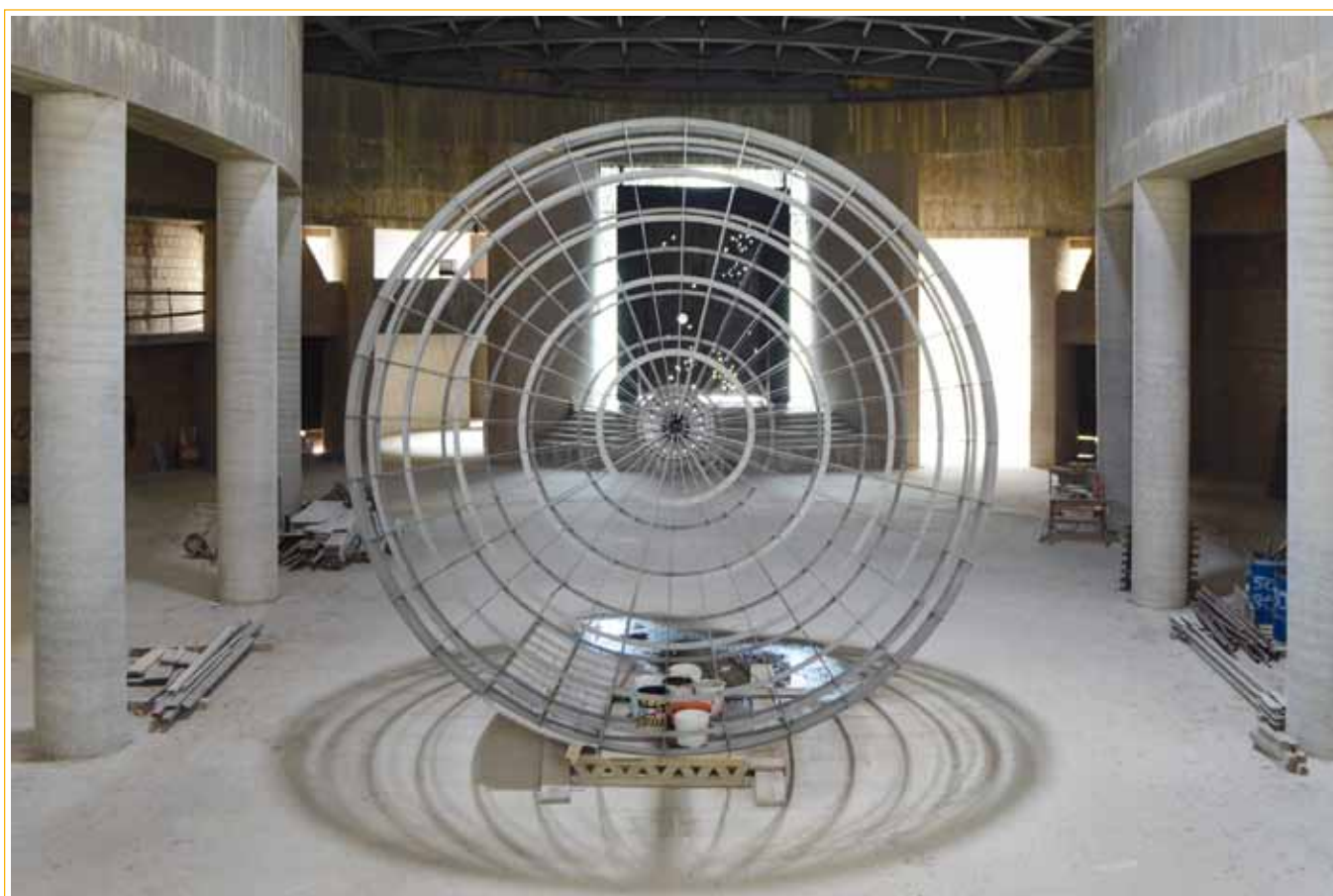
Interno dell'erigendo Santuario visto dall'abside.
