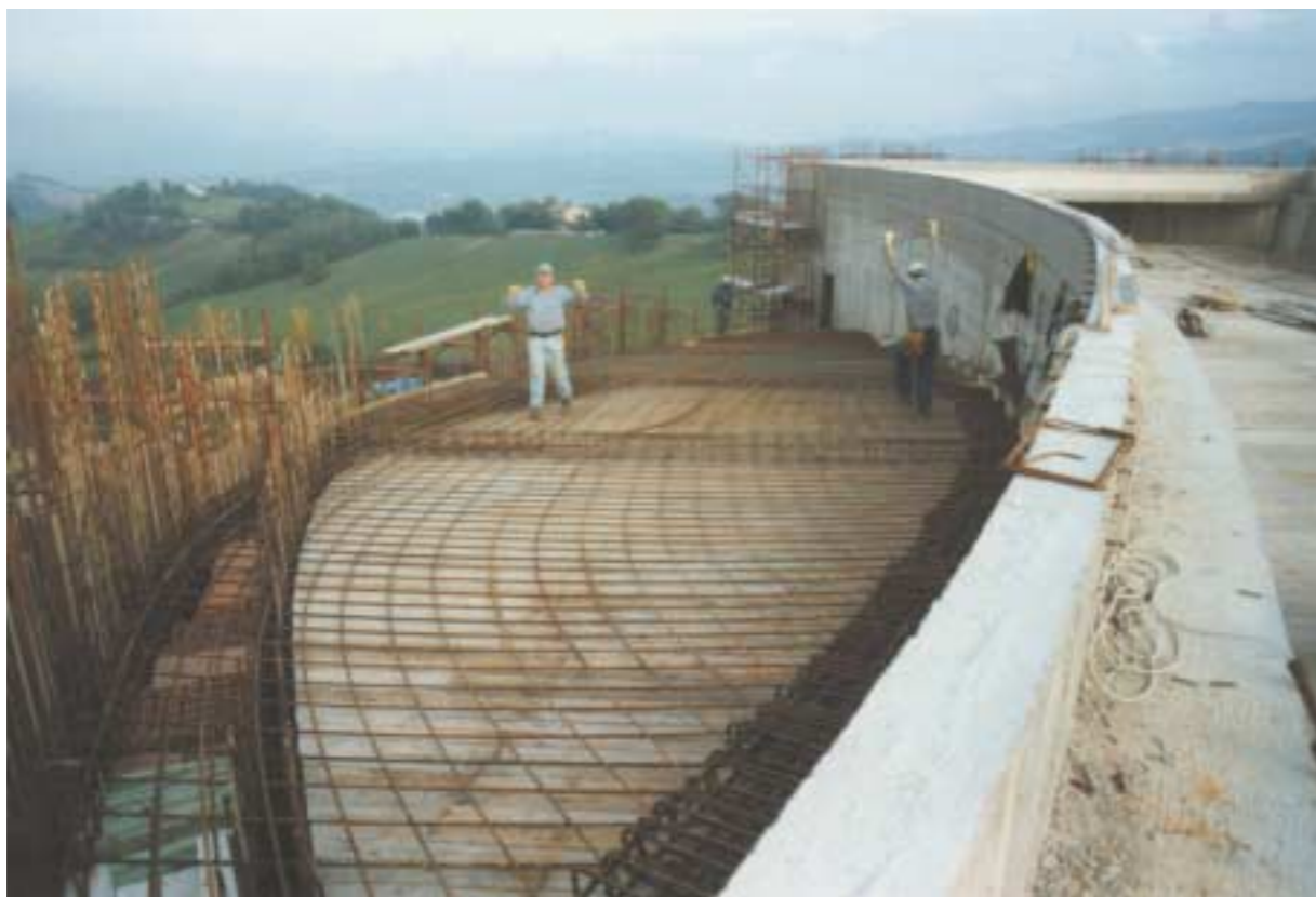
Preparazione dei ferri per l'armatura della soletta in cemento armato per copertura del Santuario della navata laterale.
