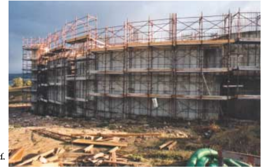
Armatura metallica per sostegno casseforme per architravi.
