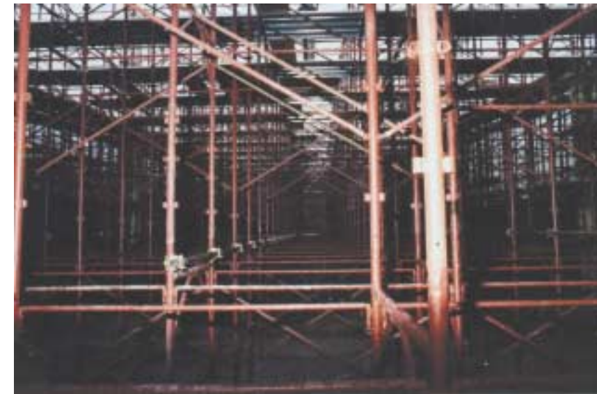
Armatura metallica per sostegno casseforme per architravi.
