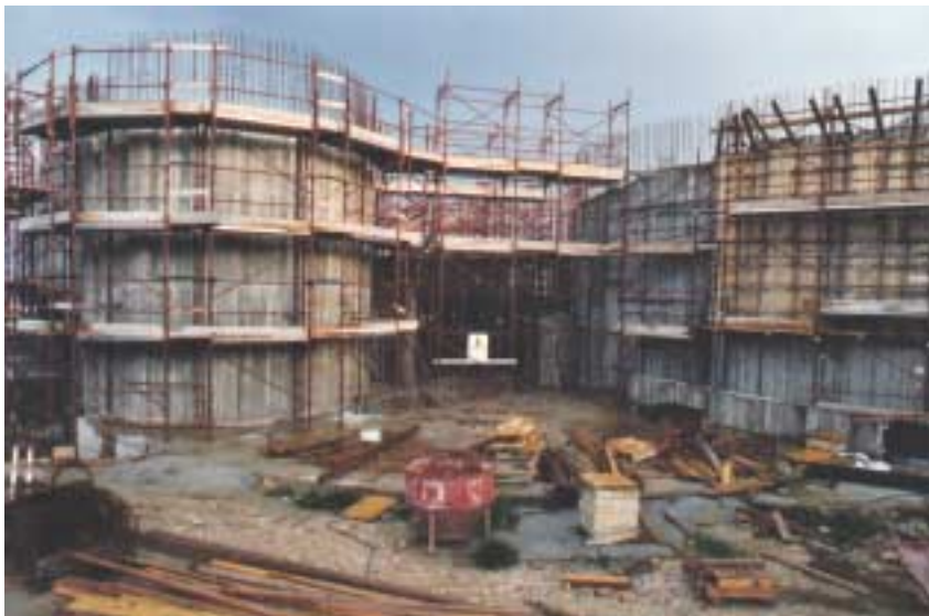
Foto Santuario lato ovest, entrata principale.
