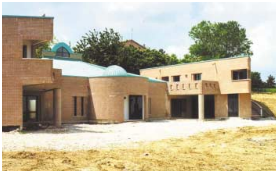
Il centro servizi di Ca' Stacolo visto da altra angolazione
