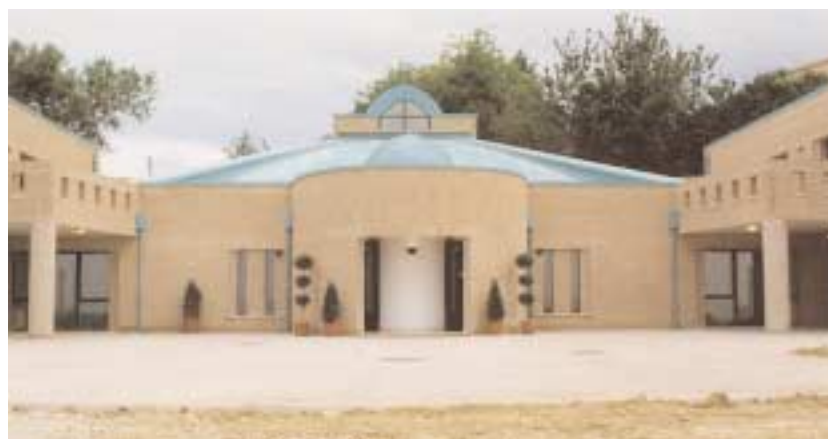
Fronte dell'edificio cappella e casa dei religiosi
