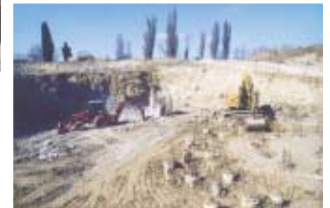
Sbancamento di terreno per la costruzione della cripta.
